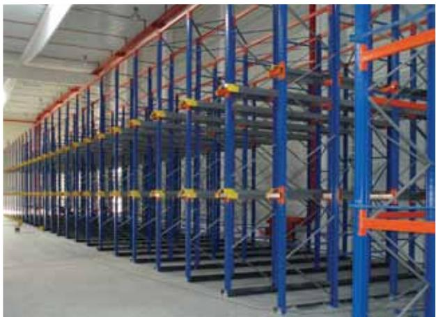
Paletové regály vjezdné slouží k ukládání palet stejného druhu zboží. Jsou určeny pro skladování zboží s malou obrátkou nebo delší dobou trvanlivosti. Palety se ukládají do regálu za sebou do kanálu (ukládací uličky) v jednotlivých řadách a v několika ukládacích úrovních.
